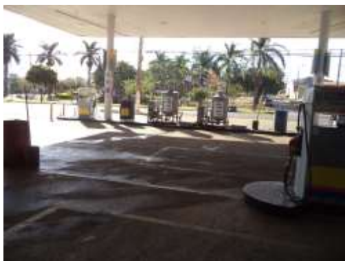
Figura 2: Vista das bombas de combustíveis
