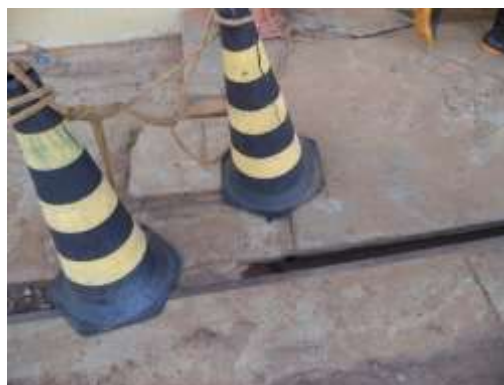
Figuras 5 e 6: canaletas de contenção em volta da pista, observar pavimentos
