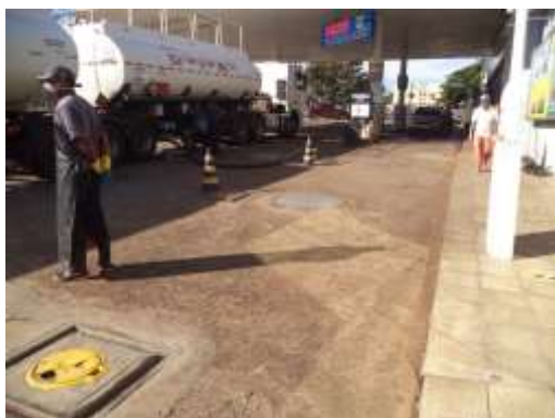
Figuras 5 e 6: canaletas de contenção em volta da pista, observar pavimentos
