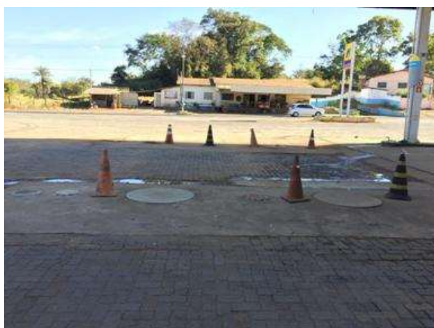
Figura 01: Vista geral da pista de abastecimento
