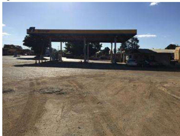
Figura 04: Área geral da área das bombas
