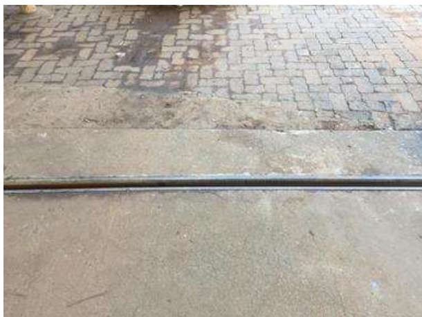
Figuras 05 e 06: canaletas de contenção em volta da pista, observar pavimentos
