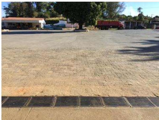
Figuras 05 e 06: canaletas de contenção em volta da pista, observar pavimentos
