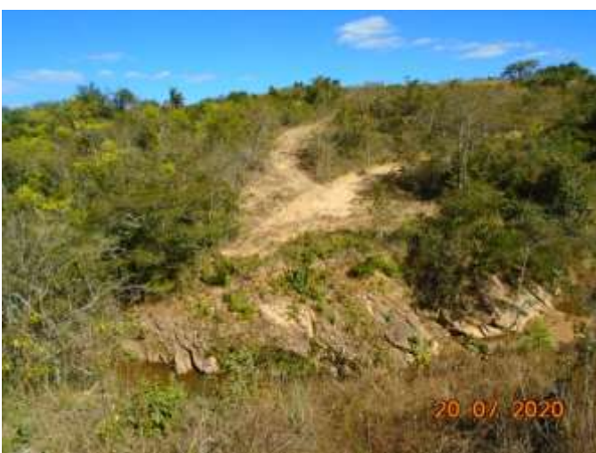
Foto 06: Vista do local da ponte
