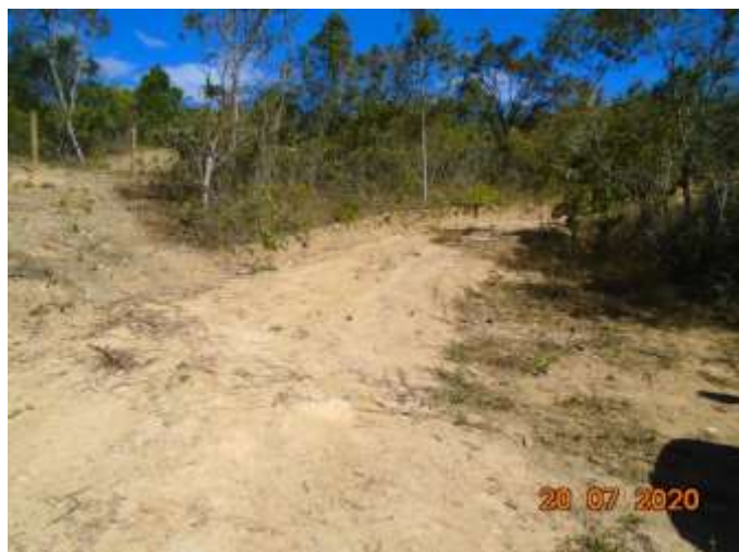
Foto 01: Vista da abertura de via
