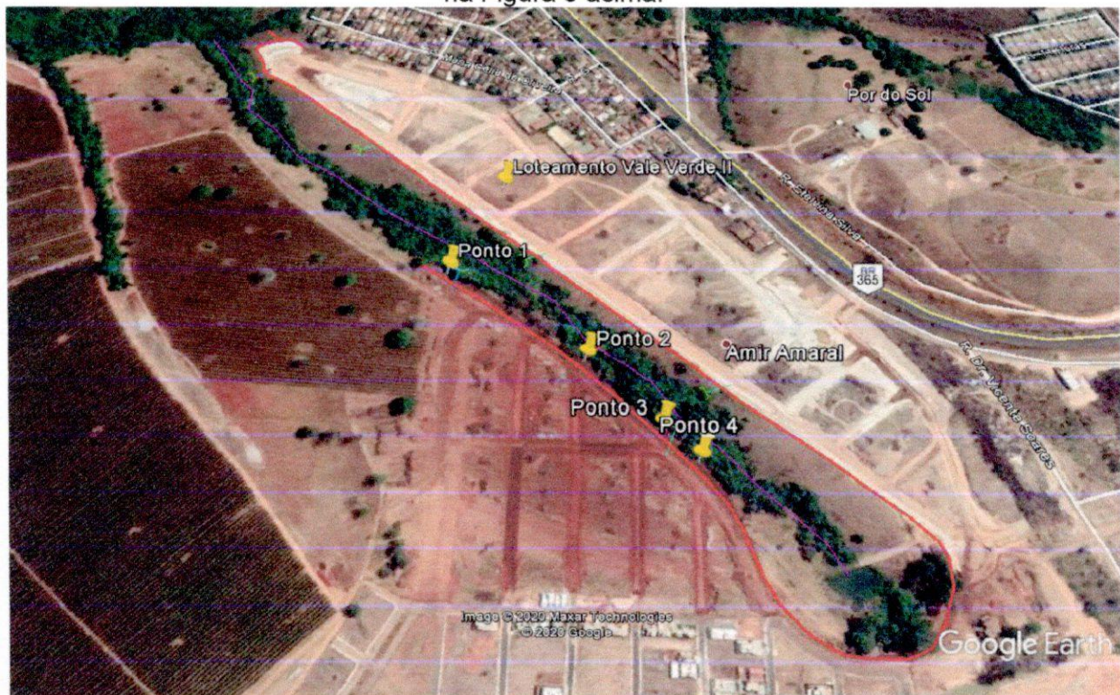
Figura 6: observar os pontos onde ficou comprovado avanço do talude na APP, em detalhe na Figura 3 acima.
