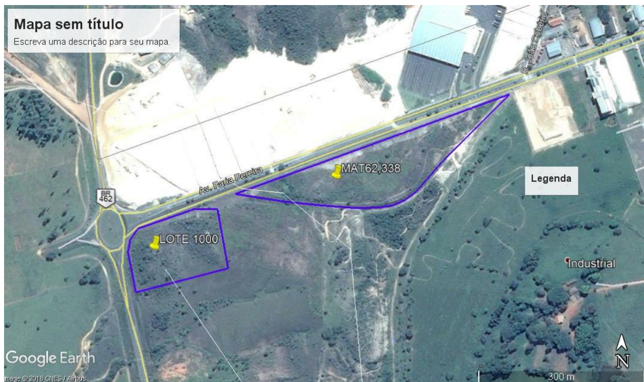
Figura 5: Vista geral da área do empreendimento- lote 1000 e os demais empreendimentos recentes do mesmo proiprietário no local (área em azul da matrícula 62.338 e também as áreas em branco – sob movimentação de terra – do lado oposto da Av. Faria Pereira)
