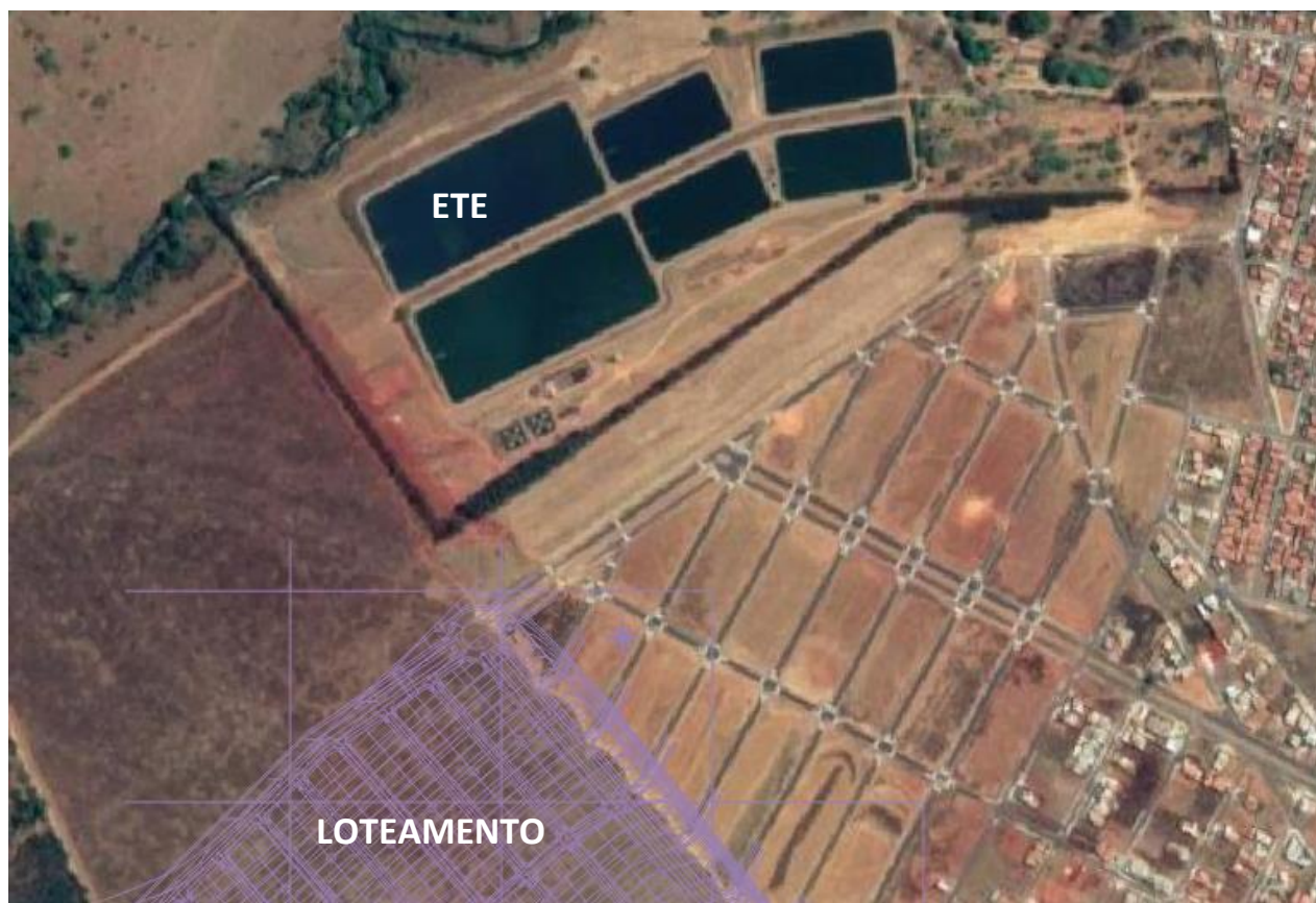
Figura 2: Imagem do loteamento e a Estação de Tratamento de Esgoto
