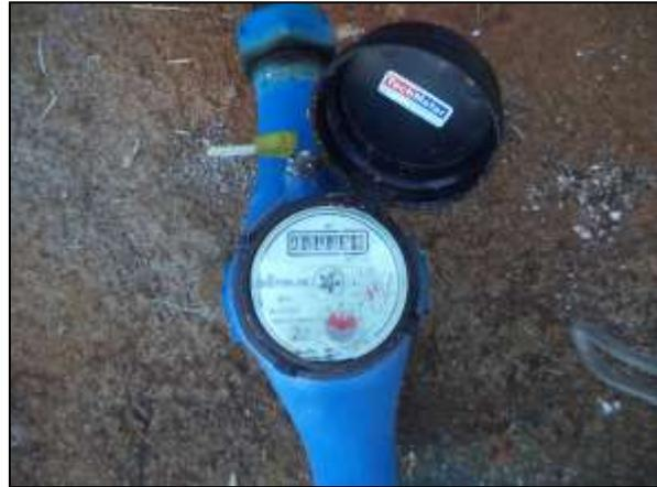
Figura 18: Hidrômetro
