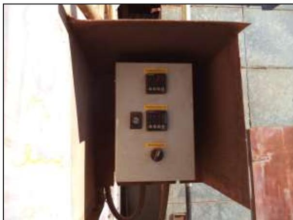
**Figura 09:** Termostato para controle da temperatura da fornalha
