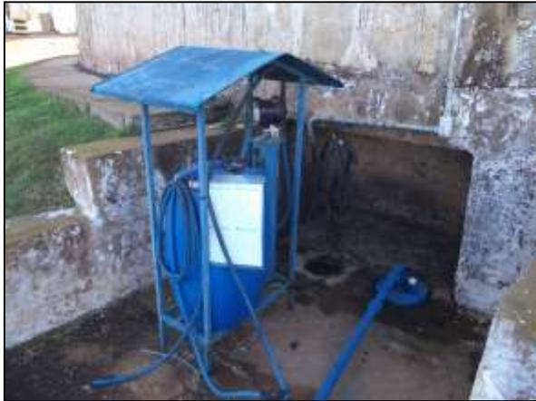
Figura 17: Poço tubular e clorador sem uso
