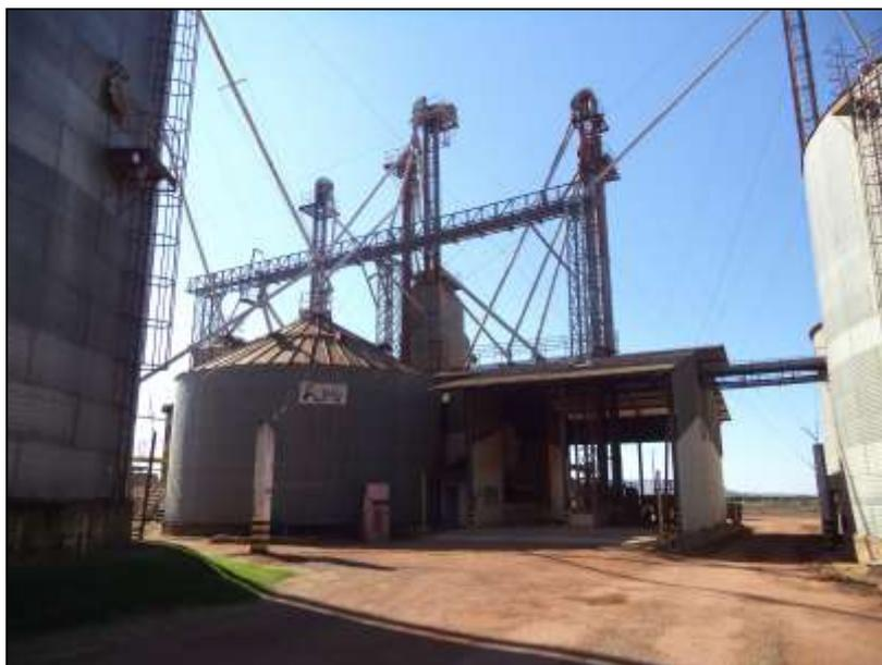
**Figura 07:** Vista do sistema de transporte dos grãos (elevadores e transportadores)
