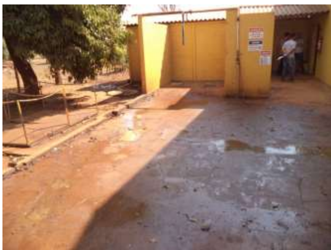
Foto 03: Pista de calda, Faz. Porta do Céu
