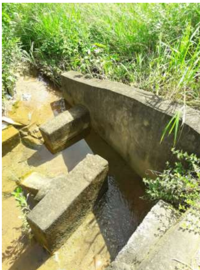
Figuras 13 e 14: vista do dissipador existente executado pelo Morada Nova IV, o qual pretende ser aproveitado
