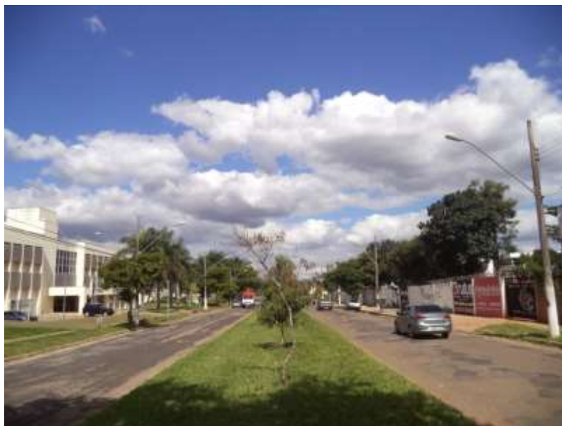
Figura 02: Parte do trecho da Avenida João Alves do Nascimento onde serão implantadas as obras.
