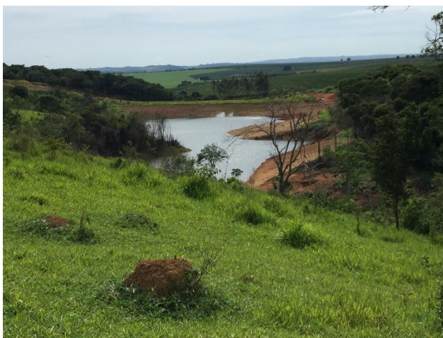
Foto 8: Barragem de irrigação
