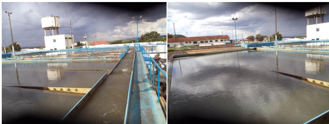
Foto 01: decantadores existentes Foto 02: vista geral dos decantadores existentes
