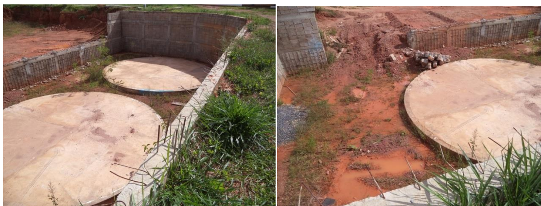
Fotos 03 e Foto 04: Fundação executada na área das obras que esse encontram paralisadas
