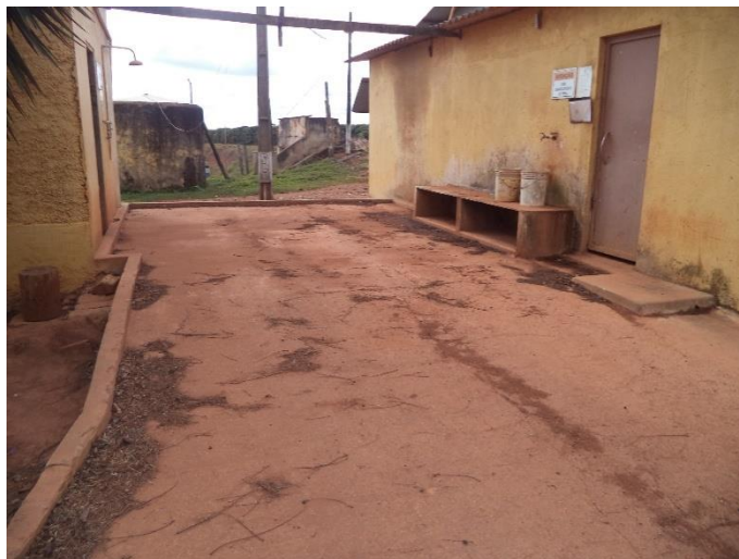
Foto 06: Pista mistura de calda, Fax. Recanto
