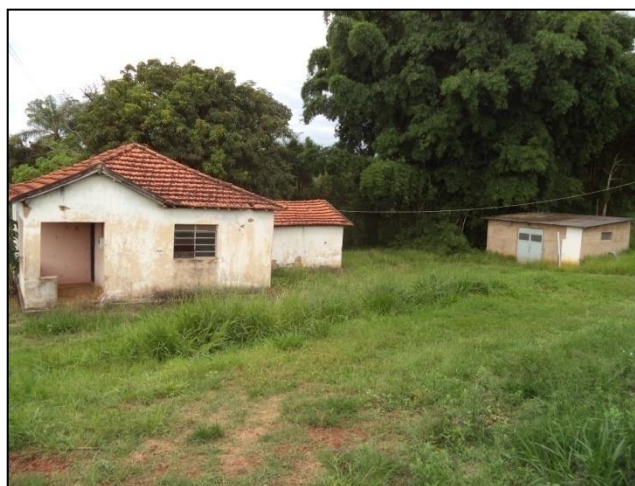
Foto 02: Casa utilizada para depósito
