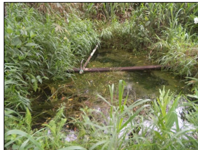
Foto 08: Captação em água de surgência
