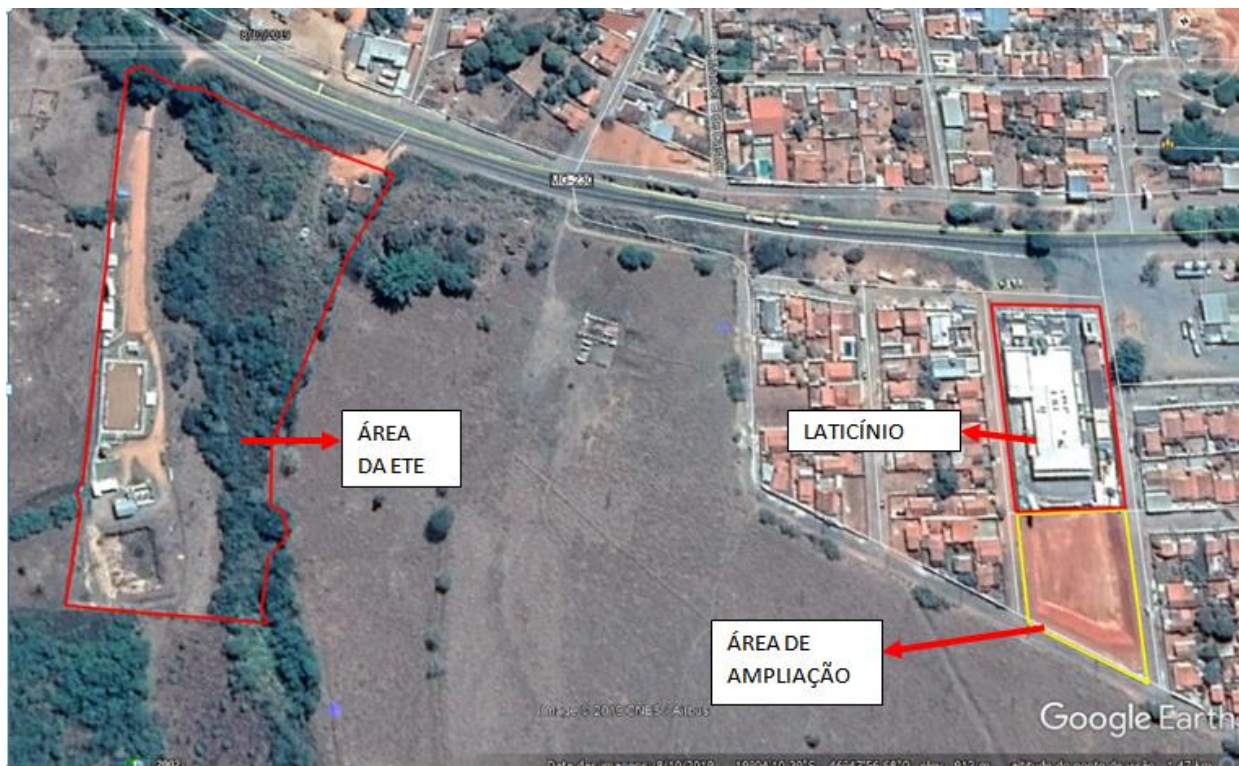
Figura 1: Visão geral do empreendimento
