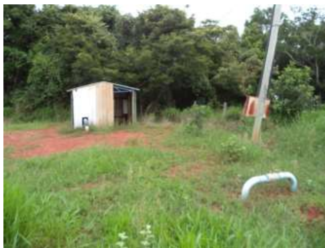
Foto 4: Casa de máquinas
