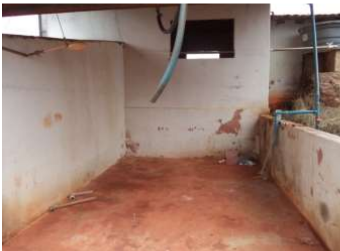
Foto 2: Pista de calda
