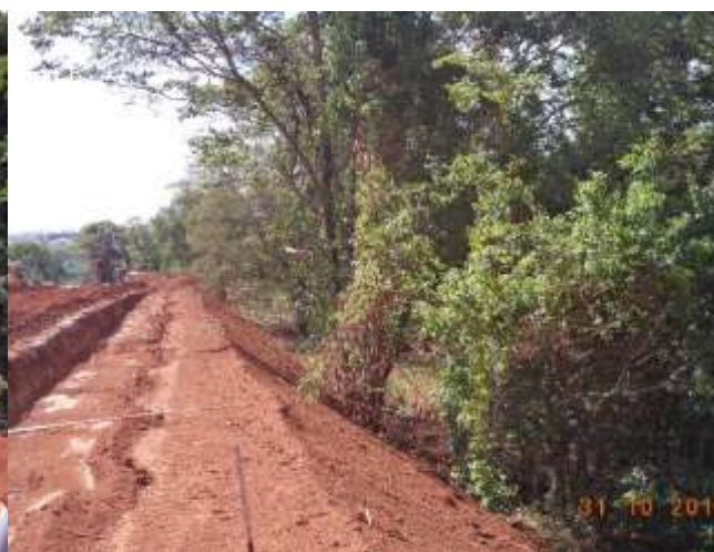
Fotos 25 e 26: talude na rua Joaquim Barbosa Arantes, trecho quase final da rua, observar a altura do talude, sem proteção, além da invasão na APP.
