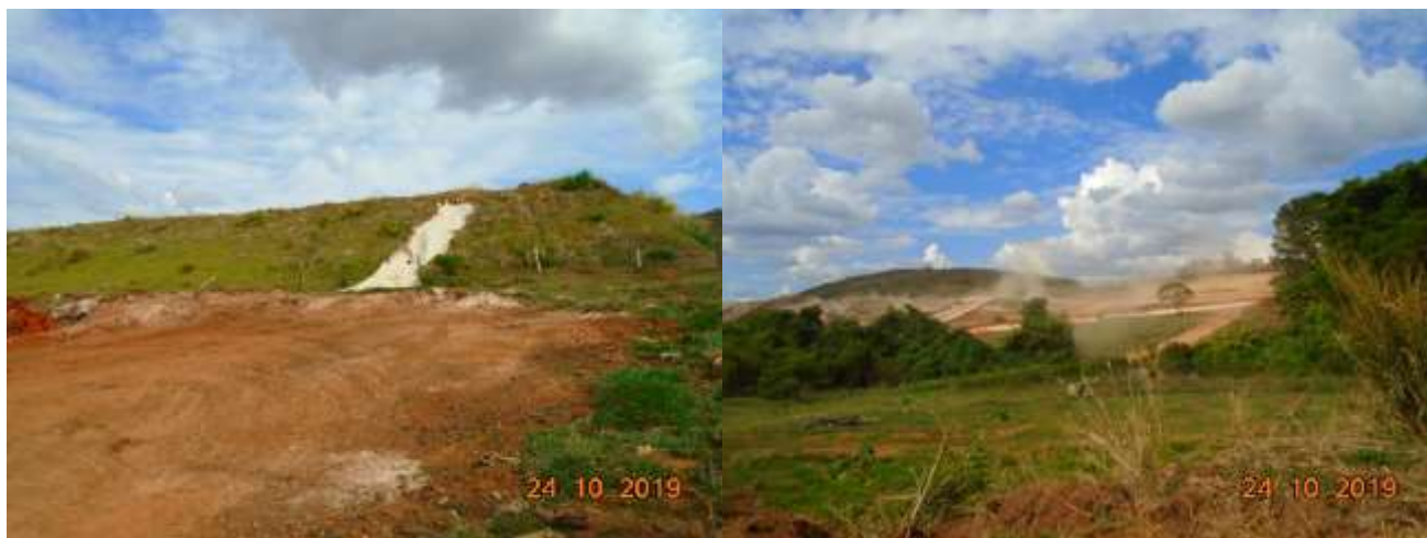
Fotos 3 e 4: corte no terreno natural: ações de terraplanagem no lado do bairro Amir Amaral.
