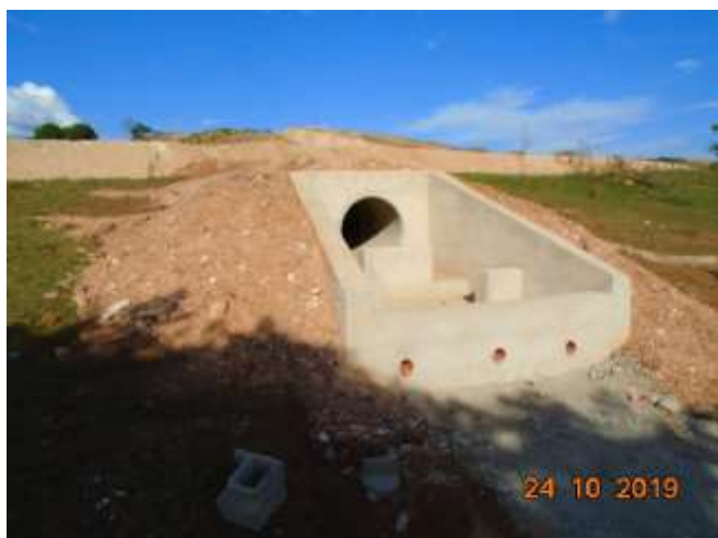
Fotos 23 e 24: dissipador do talude na rua Dirce Alves de Melo. Observar a altura do talude, sem proteção.
