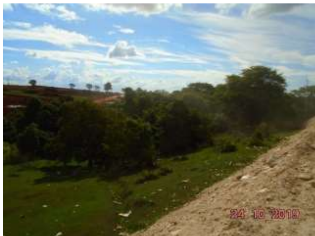
Foto 15: saia do talude na rua Dirce Alves de Melo No lado do loteamento que situa no Amir Amaral.
