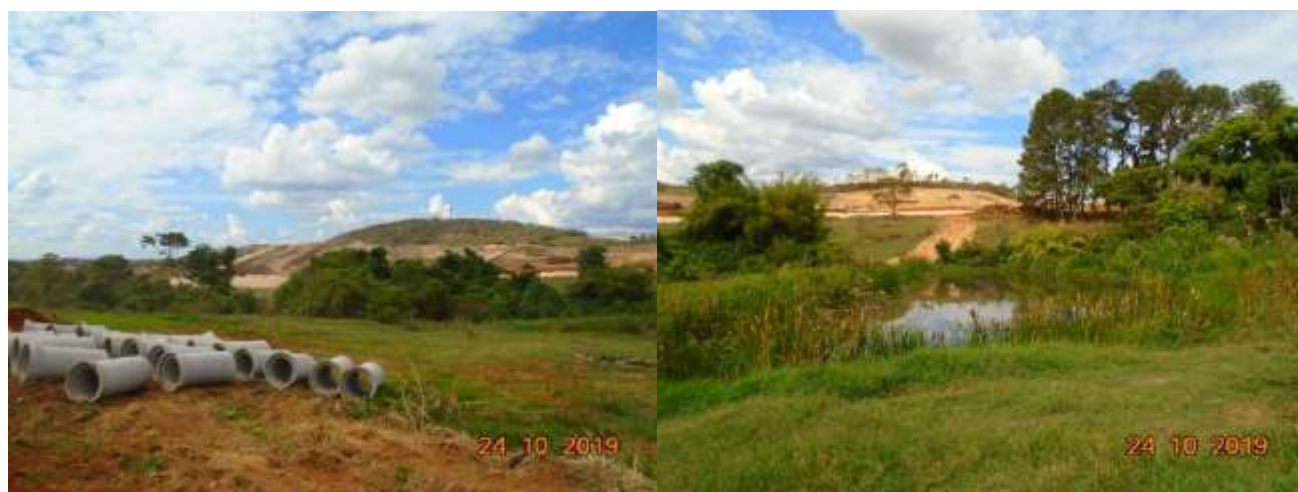
Fotos 5 e 6: vista ao fundo da área em corte no lado do Amir Amaral. À frente início da área de APP.
