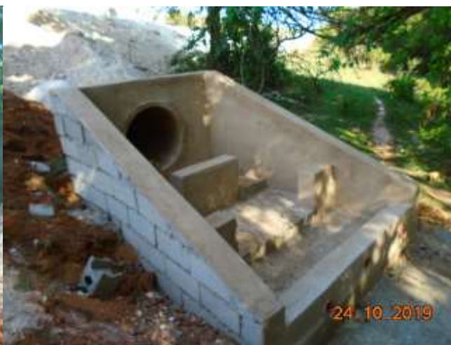
Fotos 21 e 22: outros dissipadores que nascem do talude na rua Dirce Alves de Melo, ainda em obras
