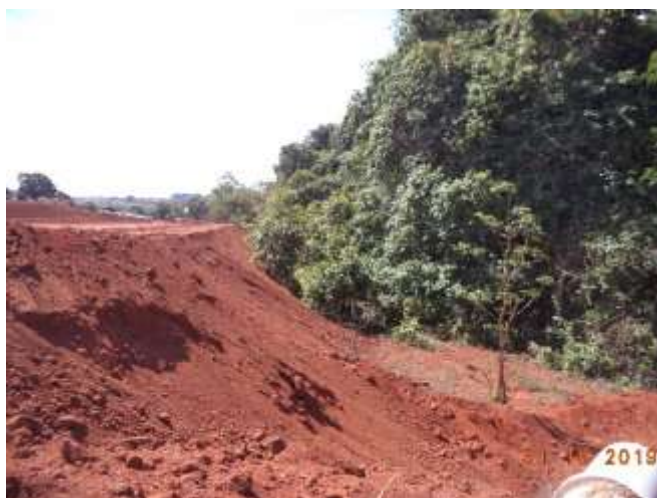
Fotos 25 e 26: talude na rua Joaquim Barbosa Arantes, trecho quase final da rua, observar a altura do talude, sem proteção, além da invasão na APP.
