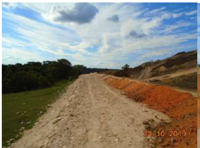
Foto 13: saída do talude na rua Dirce Alves de Melo Onde o talude ainda está em obras.
