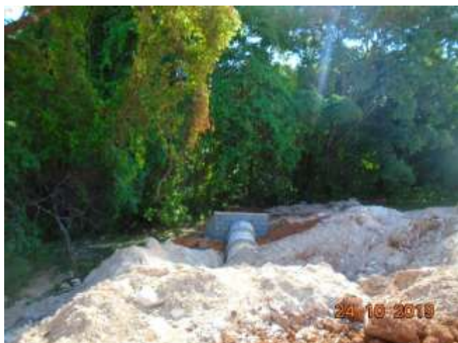
Fotos 21 e 22: outros dissipadores que nascem do talude na rua Dirce Alves de Melo, ainda em obras
