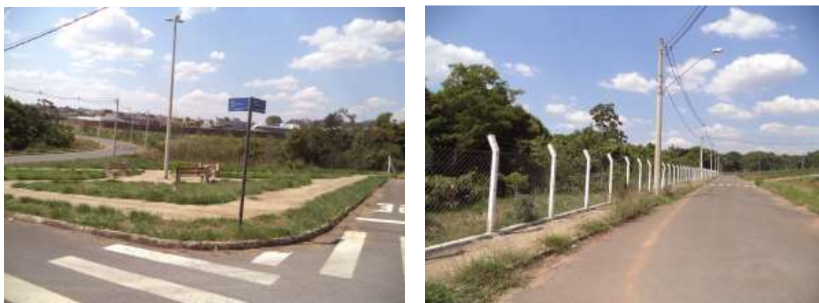
Figuras 10 e 11: região da pracinha que recebe inundações, objeto de obras de drenagem.
