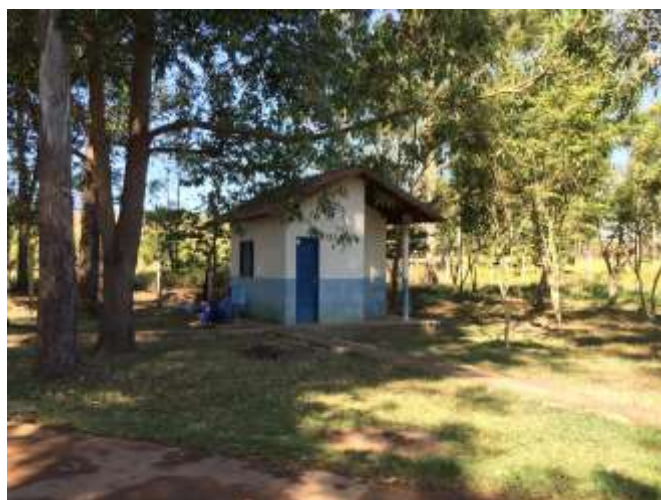
Foto 02: Casa de controle
