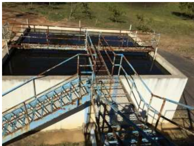
Foto 08: Filtro anaeróbio
