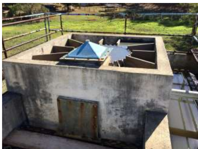
Foto 05: Reator UASB - difusor
