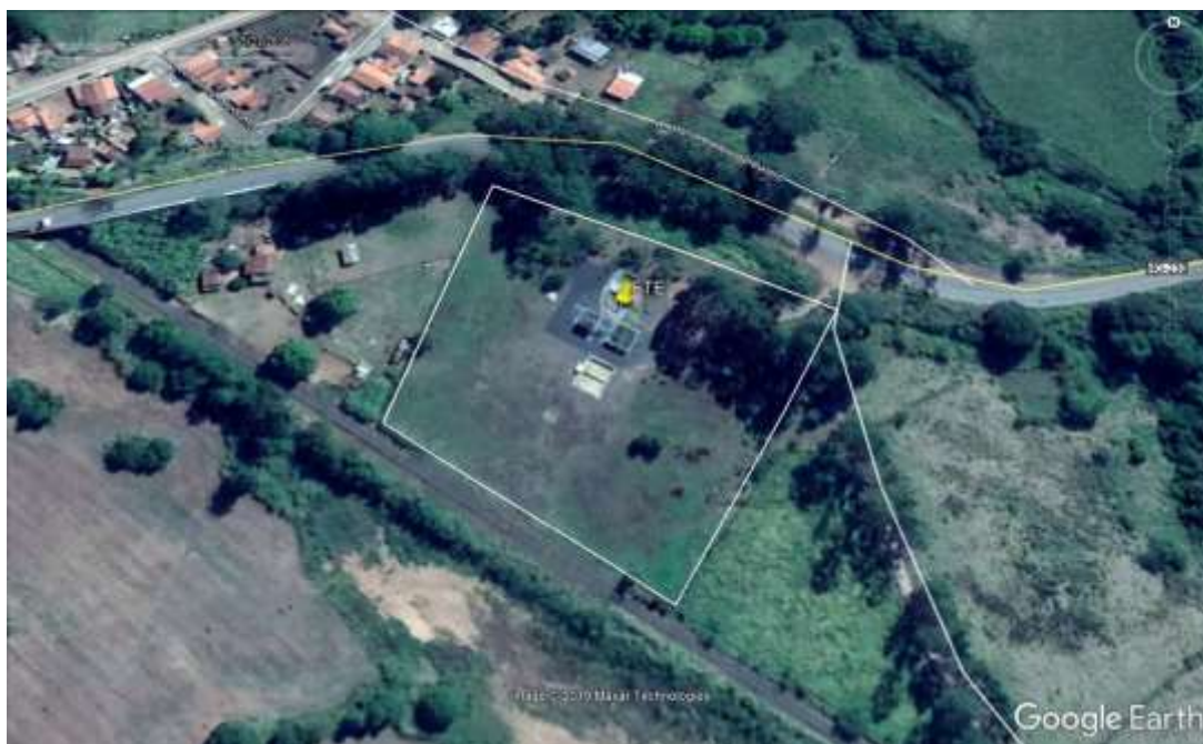
Figura 01: Imagem aérea da área abrangida pela ETE. Fonte: Google Earth
