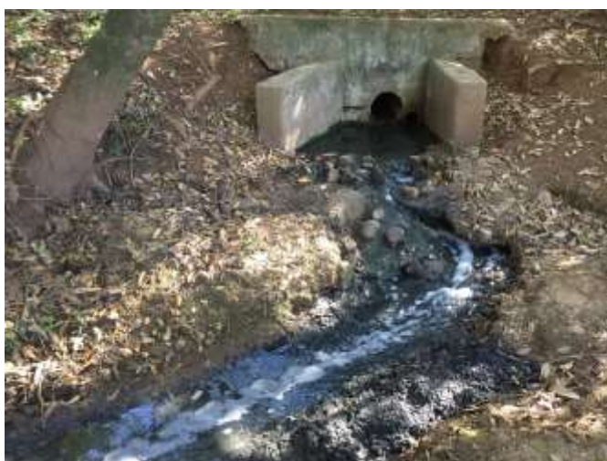
Fotos 11 e 12: Ponto de lançamento do efluente tratado – Ribeirão Salitre
