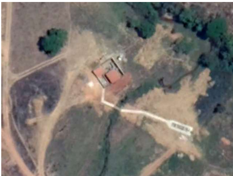
Figura 02: Vista aérea do TP e estação elevatória.
