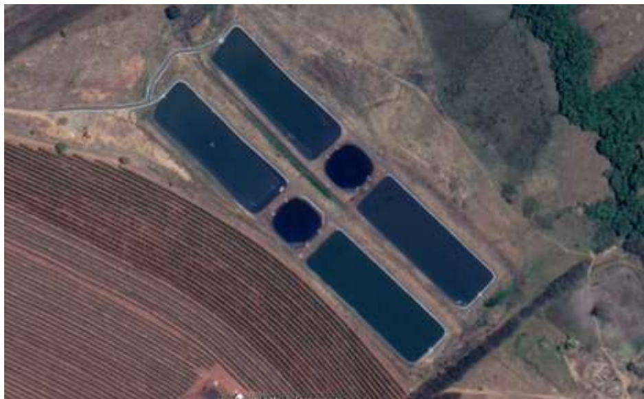
Figura 01: Vista aérea da ETE Bairro Serra Negra.
