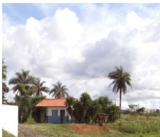
Figura 23: Banheiro da ETE
