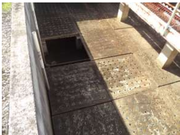
Figura 09: Filtro anaeróbio
