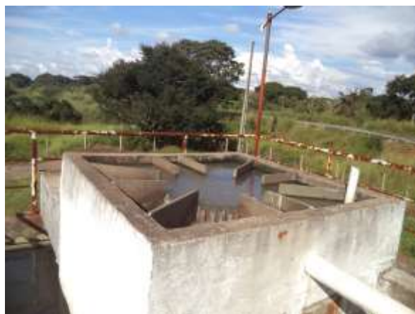
Figura 10: Reator anaeróbio
