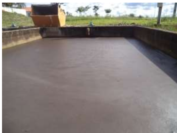
Figura 05: Leito de secagem
