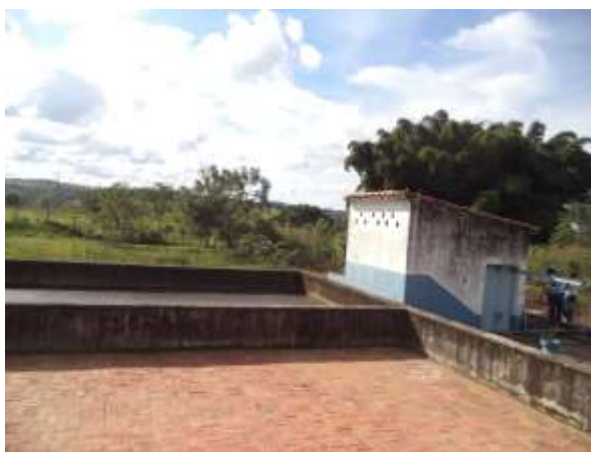
Figura 15: Vista da casa das bombas
