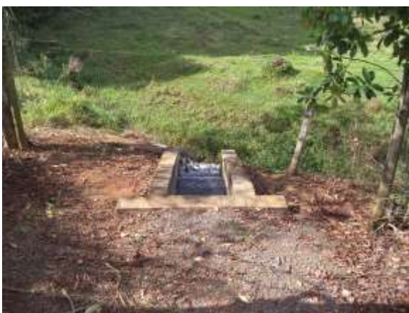
Figura 18: Vista do emissário de esgoto na APP
