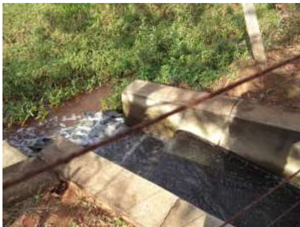
Figura 19: Ponto de lançamento do efluente tratado Figura 20: Observar espuma na área de lançamento, indicando a presença de detergentes no efluente
