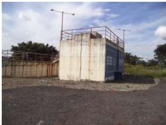
Figura 13: Vista da área dos reatores
