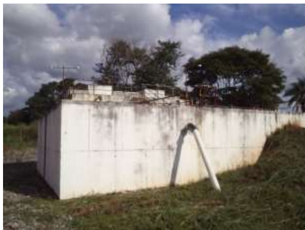
Figura 08: Vista da tubulação que conecta o tratamento primário e conduz o lodo ao leito de secagem
