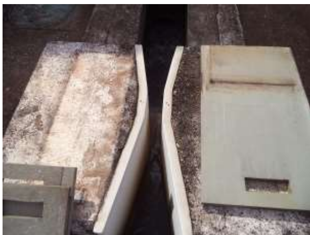
Figura 03: Calha Parshall
