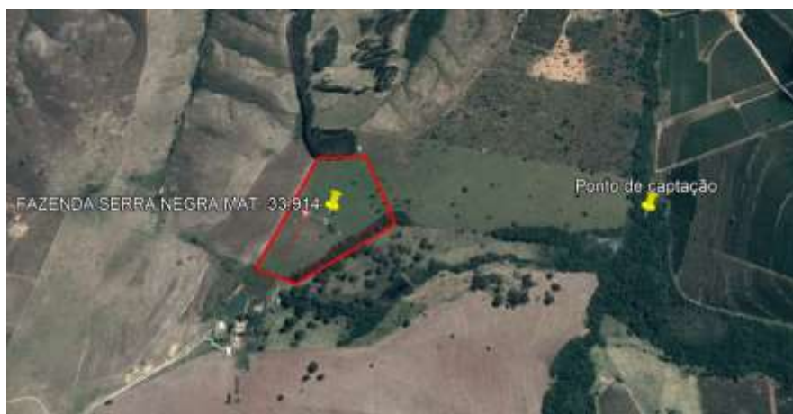
Figura 02: Observar ponto de captação hídrica em outro imóvel, também de propriedade do Sr. Adelvando.
