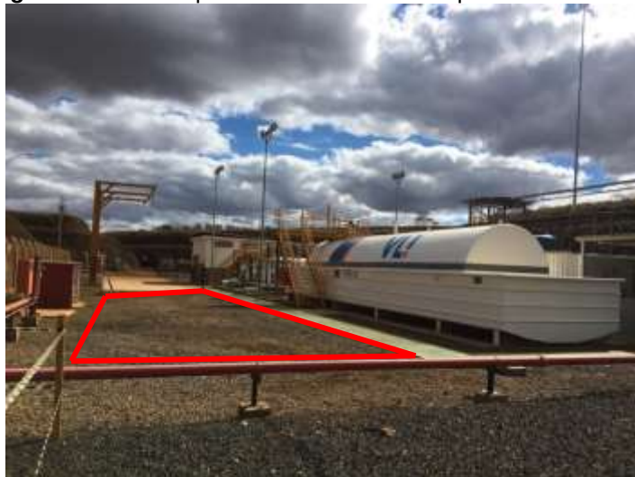
Figura 2: Área na qual será instalado o tanque de combustível
