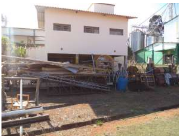
Figura 16: Disposição de peças metálicas em ambiente sem cobertura e diretamente no solo
