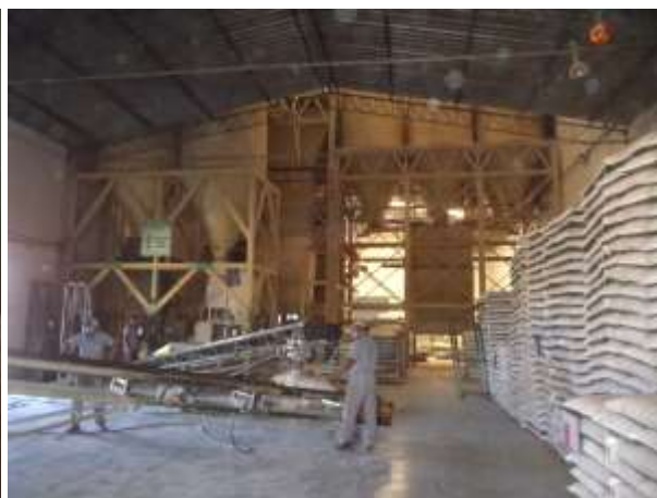
Figura 06: Área interna da fábrica de rações
