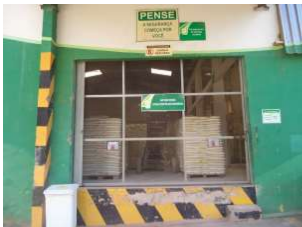
Figura 11: Observar aberturas com tela nas fábricas, Figura 12: Observar cobertura da caçamba de lixo A fim de propiciar melhor ventilação do ambiente de trabalho
