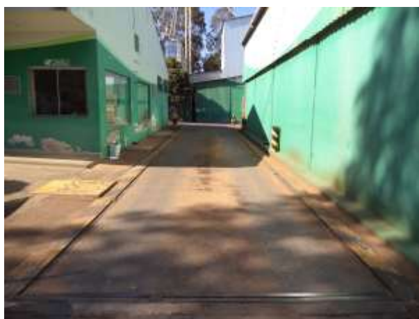
Figura 02: Balança de pesagem dos caminhões
