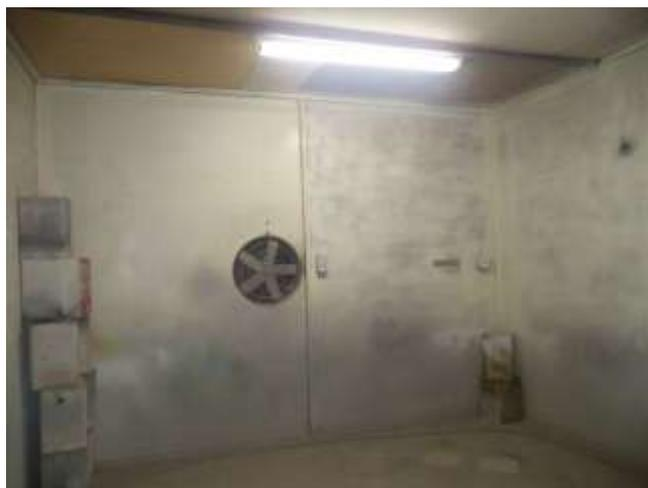
**Foto 04:** Cabine de pintura com sistema exaustor
