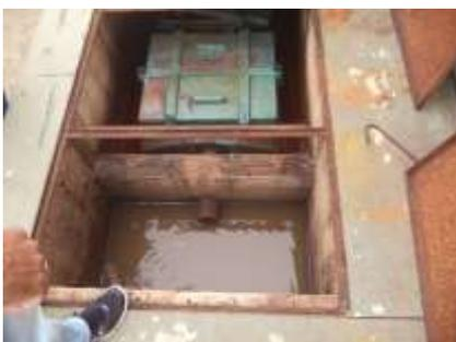
**Figura 05:** Caixa separadora de água e óleo
