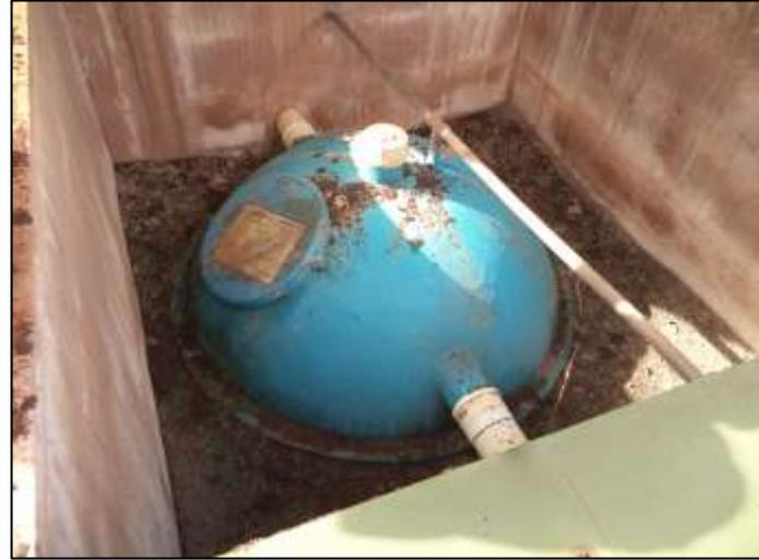
**Foto 07 e 08:** Piscinão para manejo hídrico e biodigestor para tratamento do efluentes domésticos.
