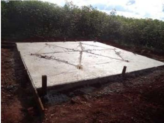
**Foto 05:** Base em concreto do reservatório
