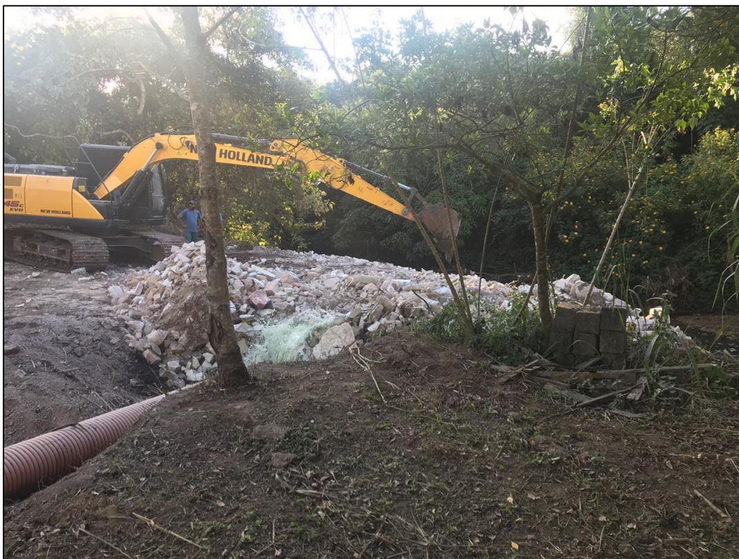
Foto 02: Ponto de lançamento do efluente tratado.
