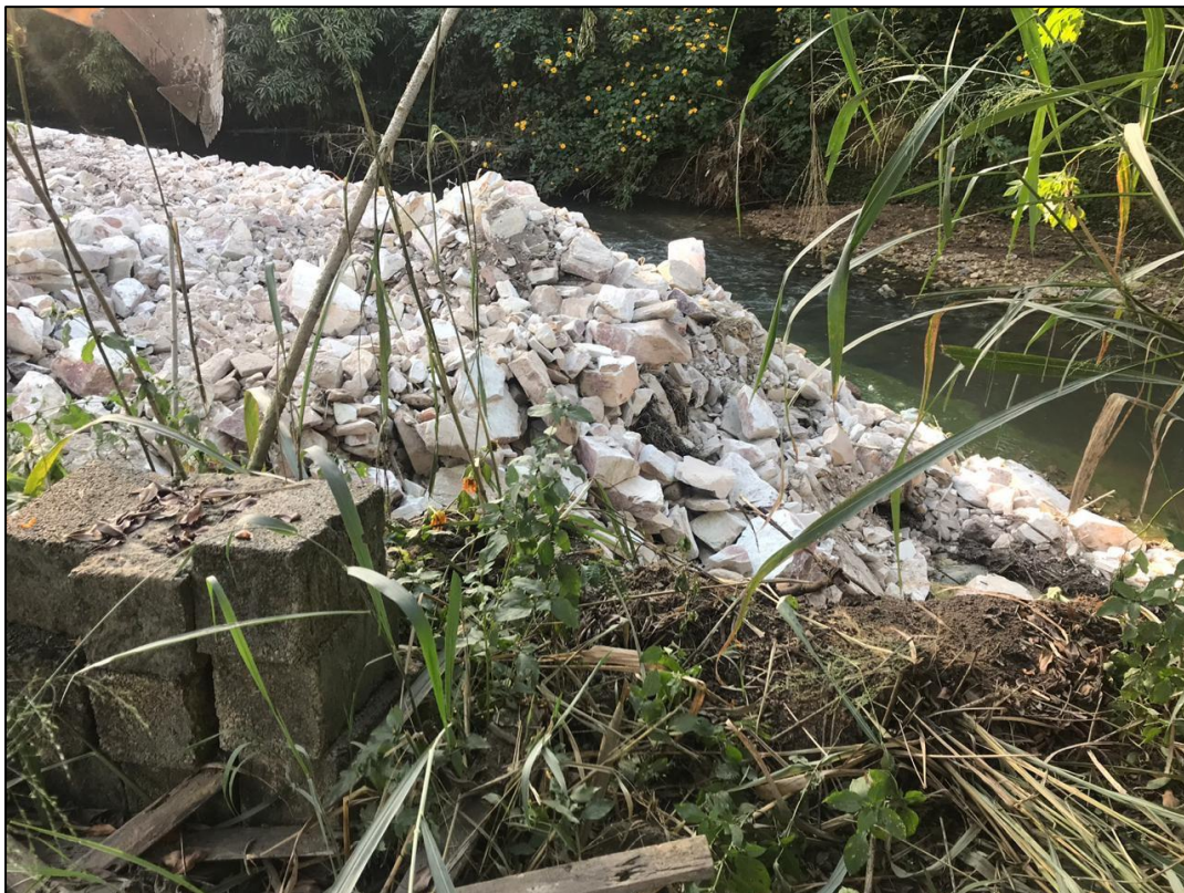
Foto 01: Pedras sendo colocadas na área da erosão.
