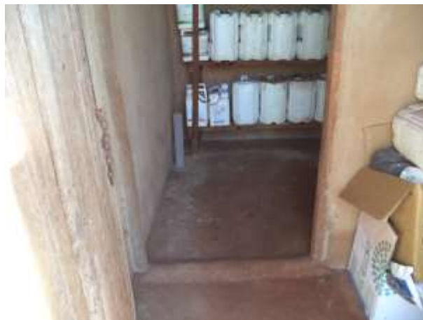
Figura 13: Observar mureta de contenção de possíveis vazamentos
