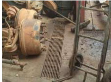
Foto 14: grelha no corredor para destinar efluente à caixa Separadora de Água e Óleo
