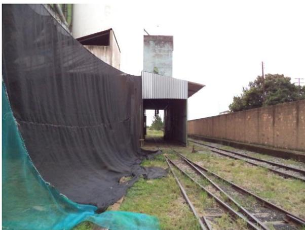
Figura 18: Observar telas de contenção de pó
