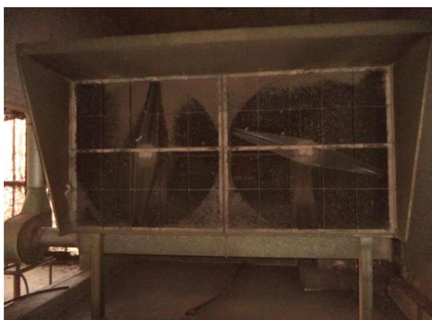
Figura 15: Exaustor com filtro advindo do secador de grãos
