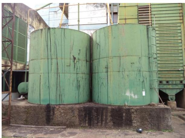
Figura 19: Tanques de armazenamento do óleo B.P.F
