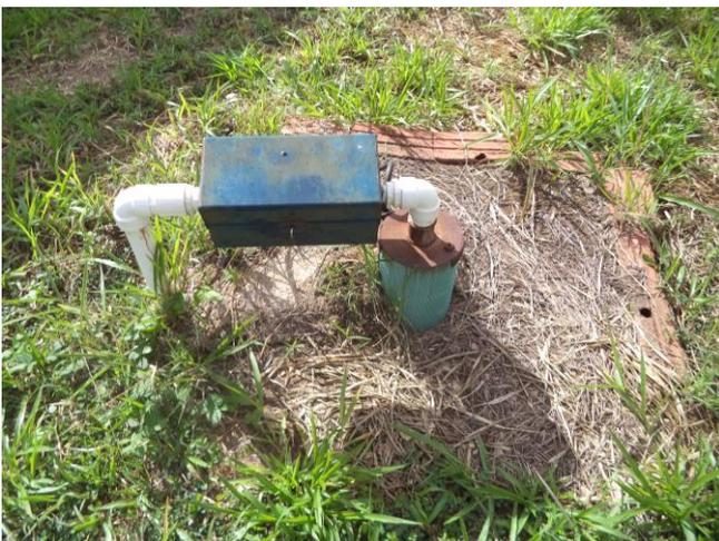
**Figura 03:** Poço tubular
