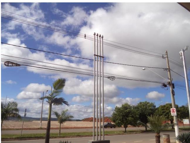
**Figura 15:** Respiros dos tanques
