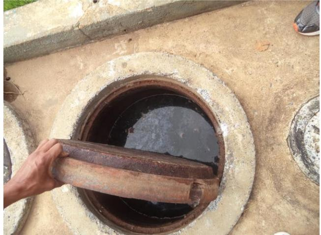
**Figuras 05 e 06:** Caixa separadora de água e óleo
