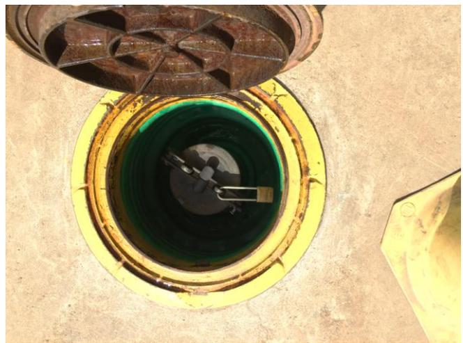
**Figuras 13 e 14:** Sistema de armazenamento de combustíveis subterrâneo
