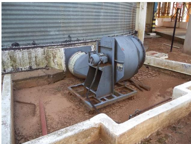
Foto 06: Sistema de ventilação dos silos
