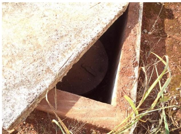
Foto 12: Biodigestor com sumidouro
