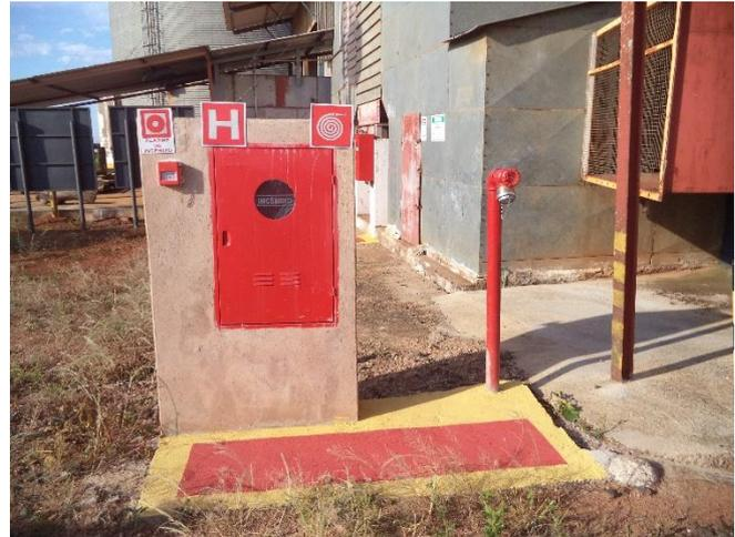
Foto 20: Hidrante de combate a incêndio
