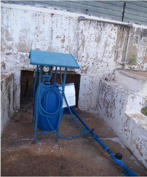
Foto 13: Sistema de cloração - Poço Tubular
