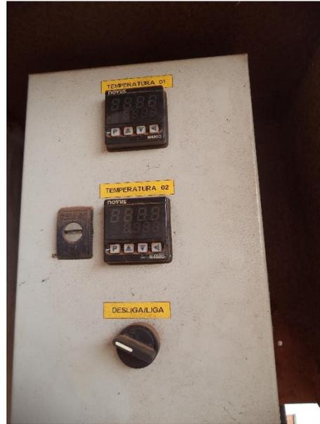
Foto 08: Termostato da fornalha
