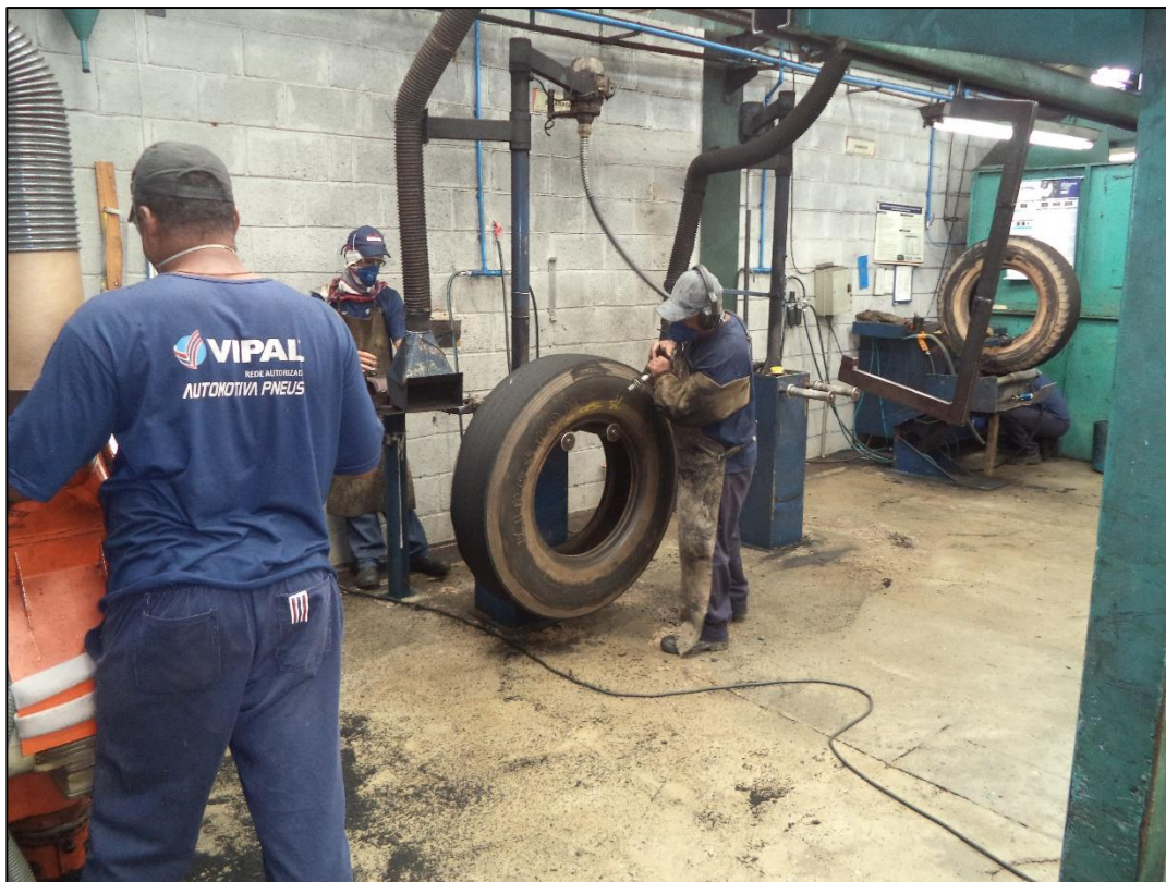
Foto 03: Área de raspagem, detalhe para o resíduo gerado.
