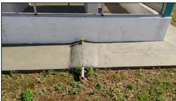
**Foto 10:** detalhe da saída da bacia de contenção
