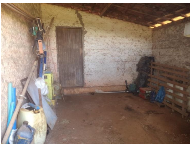
Foto 11: Garagem/depósito de ferramentas
