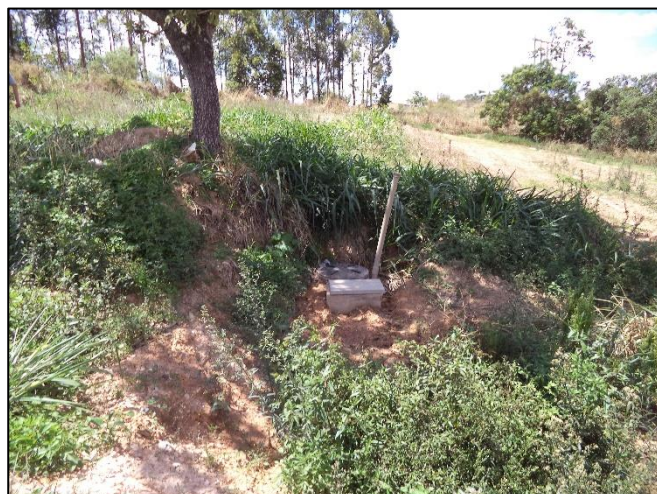
Foto 11: Vista fossa séptica.
