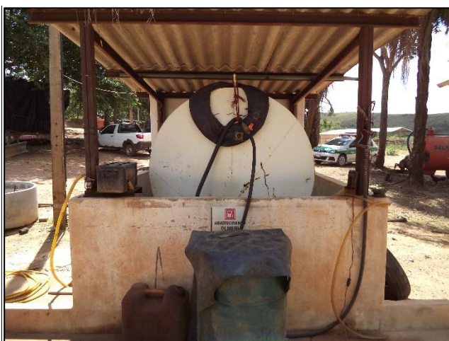
Foto 06: Ponto de abastecimento
