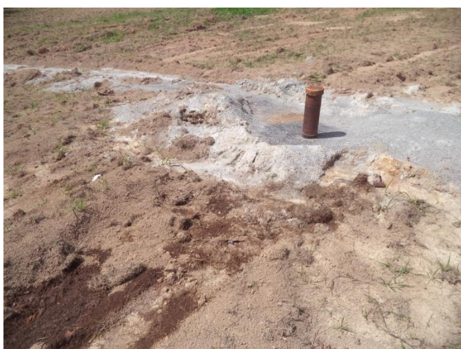
Foto 5: Poço tubular
