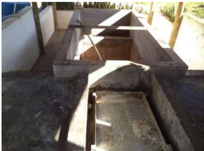
Foto 3: Caixa separadora e flotor
