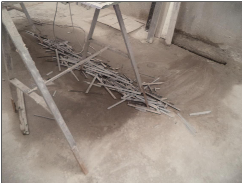
Foto 02: Vista área de corte, destaque para as canaletas e duas das cinco caixas de decantação.
