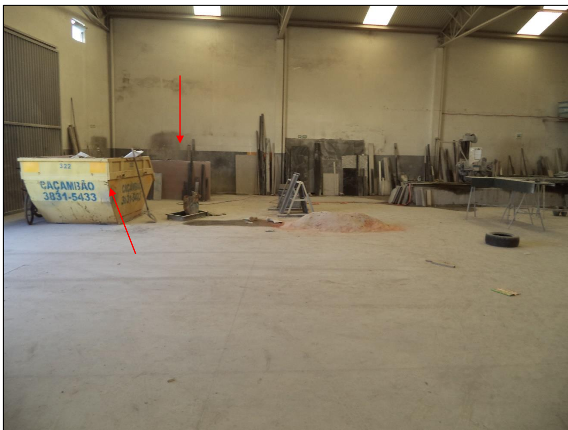
Foto 01: Vista da área do empreendimento, destaque para a caçamba de armazenamento dos resíduos sólidos, e para a parede de obstrução dos efluentes líquidos.
