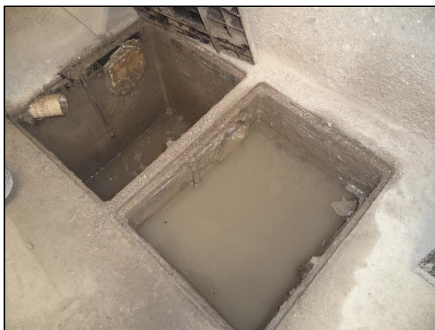
Foto 03: Vista caixa de decantação e canaletas.
