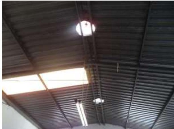
**Figura 05:** Escritório      **Figura 06:** Observar telhas translúcidas e exaustores no teto
