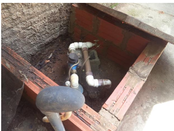
Figura 13: Poço tubular
