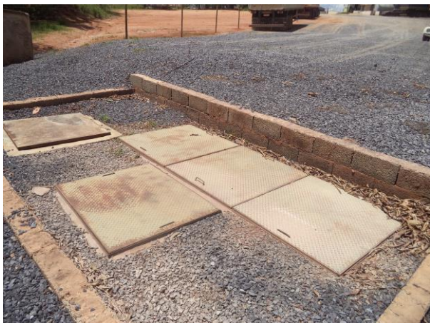
Figuras 09 e 10: Caixa separadora de água e óleo
