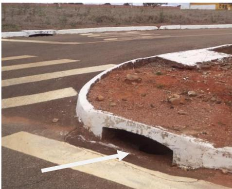
**Foto 7:** boca de lobo na esquina da Rua das Violetas com a Av. das Palmeiras – há estrangulamento da seção útil de captação na entrada da boca de lobo
