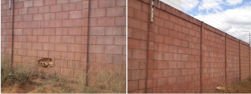
Fotos 13 e 14: saídas irregulares dos muros de divisa executadas para escoamento da água
