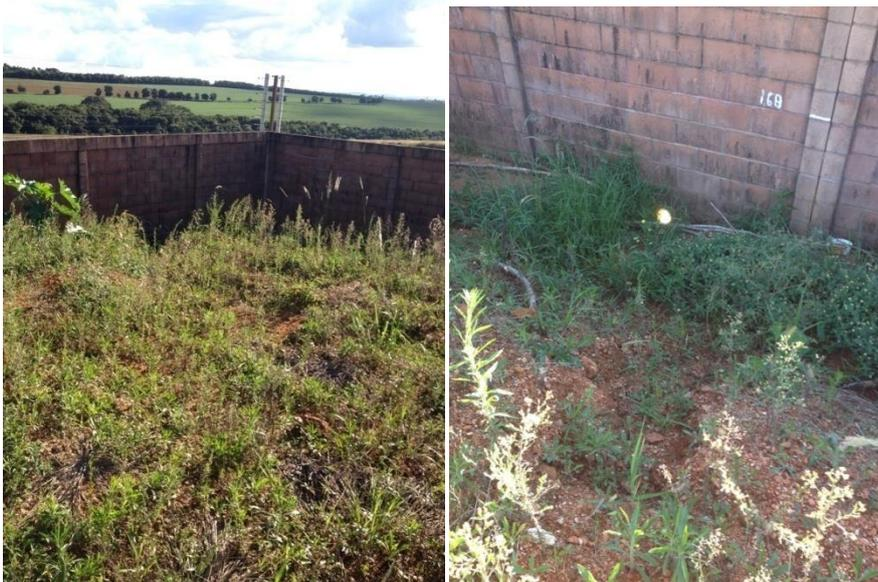
**Fotos 19 e 20:** Lote 30 da quadra 5 por onde se iniciará a nova rede de drenagem com saída para área externa – observar que o mesmo tem nível mais baixo que o nível da Rua das Violetas e onde já há uma saída precária de água de chuva.
