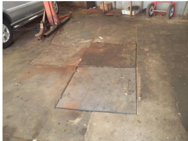
**Figura 08:** Caixa separadora de água e óleo - CSAO
