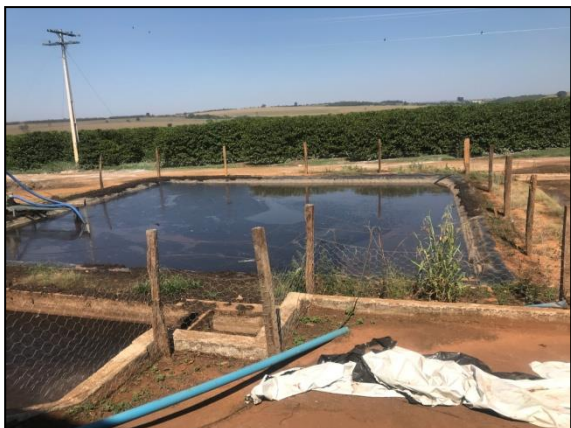
Foto 01: Lagoa de decantação
