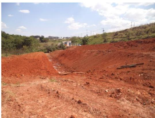
**Figuras 07 e 08:** Observar a vala de contenção de água de chuva, contígua ao dissipador 1 - obra parada
