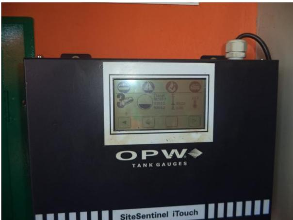
**Figura 17:** Equipamento de monitoramento de possíveis vazamentos
