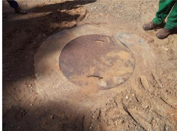
**Figura 15:** Caixa de passagem dos efluentes líquidos contidos nas canaletas
