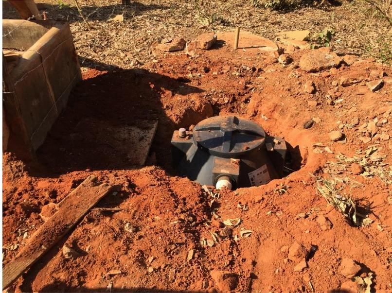
**Foto 08:** Instalação de multibiodigestor
