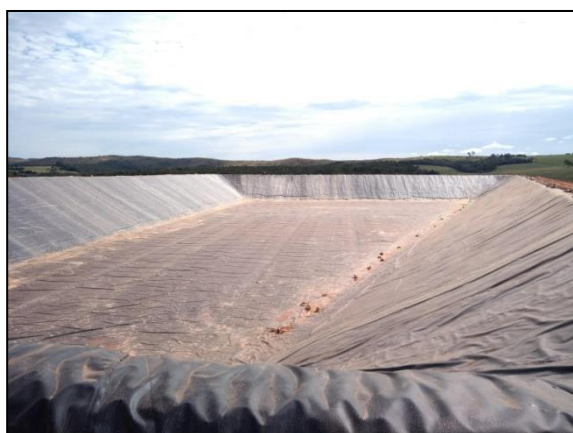
Foto 09: reservatório para irrigação
