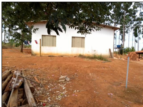
Foto 03: casa e fossa negra
